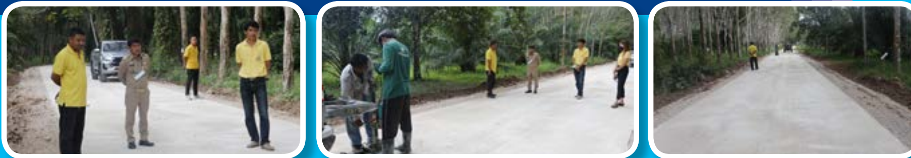
โครงการก่อสร้างถนนคอนกรีตเสริมเหล็ก สายนายเฉลิม หมู่ที่ 4 บ้านหว่างคลองแขก
