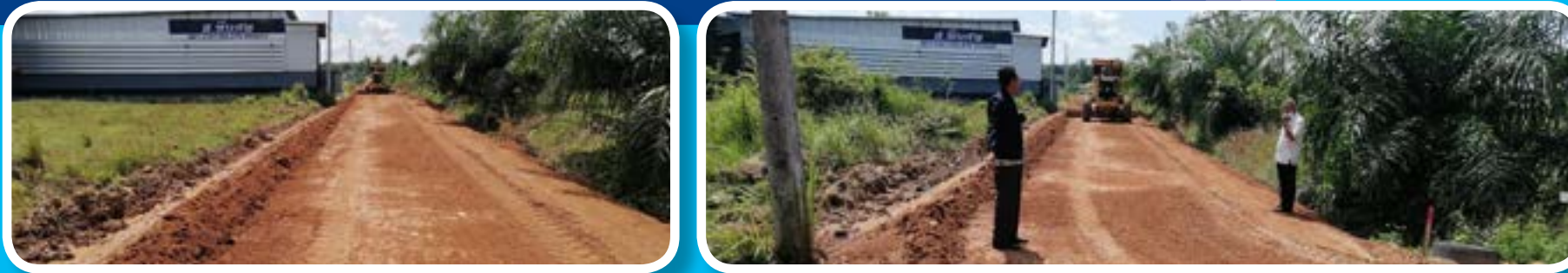
โครงการก่อสร้างถนนคอนกรีตเสริมเหล็ก ซอยหลังมิตซู หมู่ที่ 2 บ้านน้ำจวน
