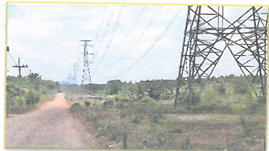
โครงการซ่อมแซมถนนลูกรัง
